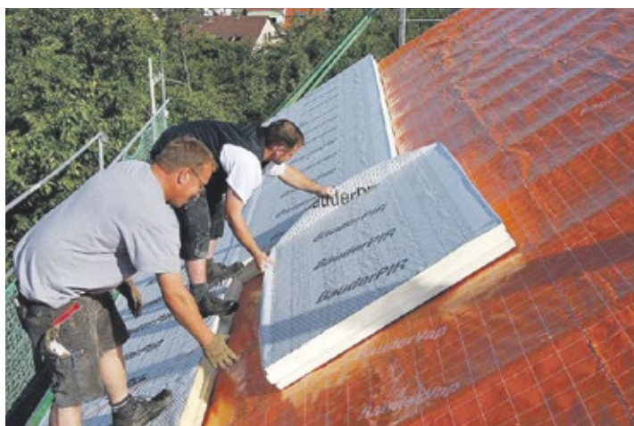
Effizient und energiesparend: Bei der sogenannten Aufsparrendämmung erhält das Dach eine geschlossene Haube aus Dämmelementen.
