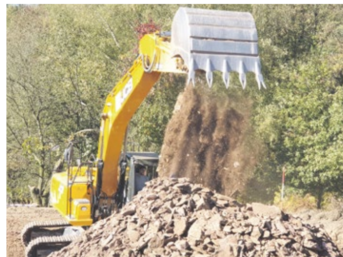
(SvG) An der Fritz-Ruhrmann-Straße in Klausen haben die Arbeiten für die neue Kindertagesstätte begonnen. Architekt Andreas Bona hat für den Investor, die Volksbank im Bergischen Land, mit einem nur von der Gartenseite sichtbaren Gartengeschoss geplant, da sich das Gebäude so optimal an die Hanglage anpassen ließ. Auf der Baustelle lässt sich diese besondere Lage schon gut erahnen. Foto: SvG
