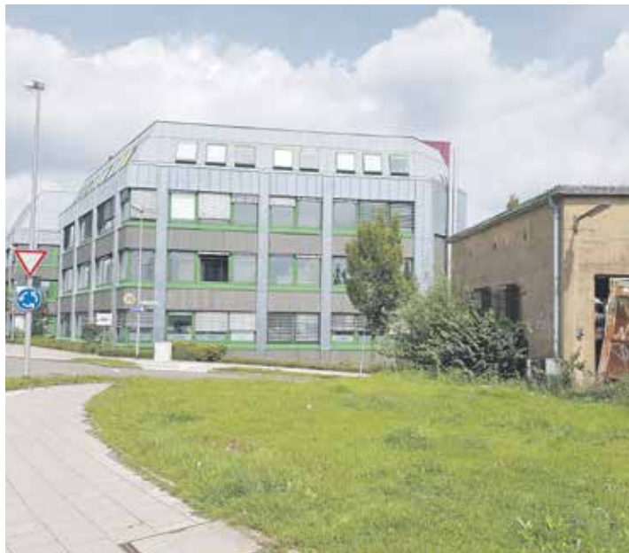
Hier könnte die Wache ein neues Domizil erhalten. Foto: Bona
