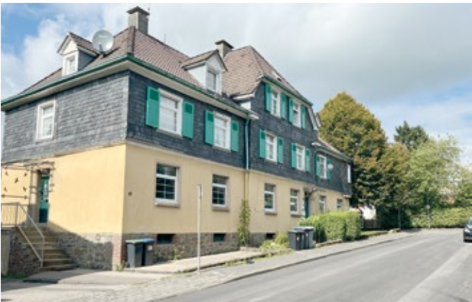
Gebäude an Richard-König-Straße und Schulstraße werden umfassend saniert. Foto: LLA
