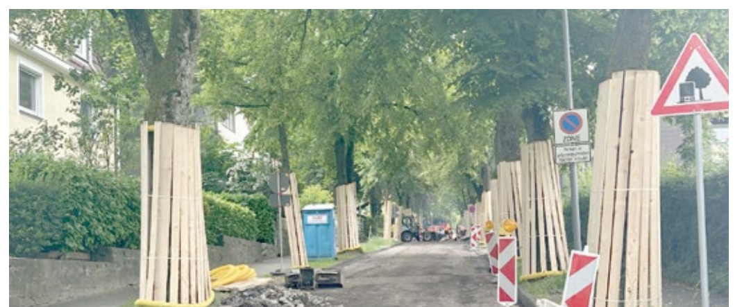
Vollsperrung in der Feldstraße: Im Rahmen des Deckensanierungsprogrammes 2026 müssen Anwohner in der Feldstraße, im Goetheweg, in der Tannenbergsstraße und in der Richard-Pick-Straße vorübergehend mit Einschränkungen rechnen. Foto: LLA
