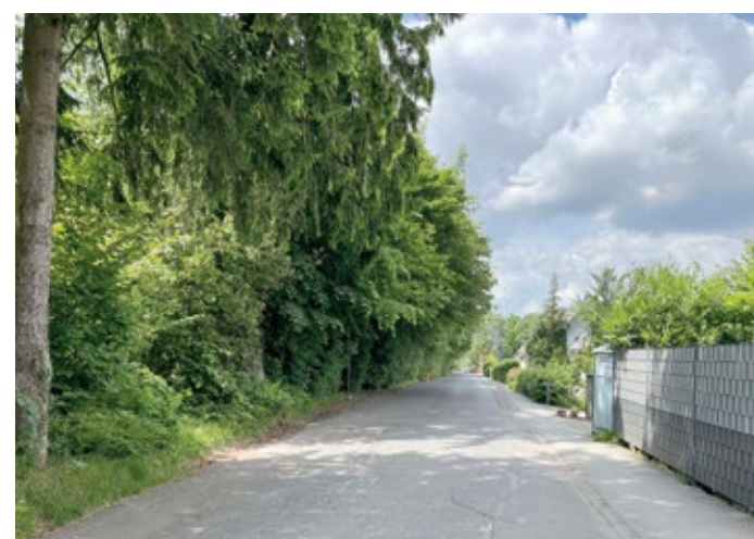
Ohne parkende Autos können Fußgänger den Albert-Tillmanns-Weg nun sicherer passieren – besonders wichtig für Schulkinder auf ihrem täglichen Weg. Foto: LLA
