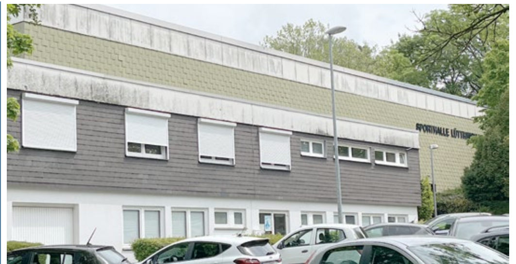
Die Dreifach-Sporthalle an der Klausener Straße in Lüttringhausen muss umfassend saniert werden. Die Kosten sind von ursprünglich 890.000 Euro auf über 1,7 Millionen Euro gestiegen.
