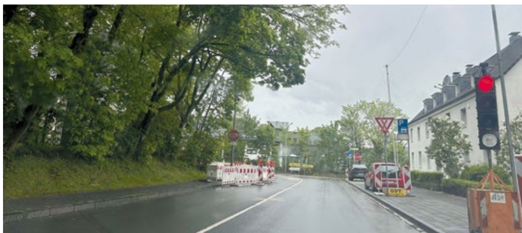
An der Kreuzbergstraße erneuert die EWR GmbH eine Stromstation. Foto: LLA
