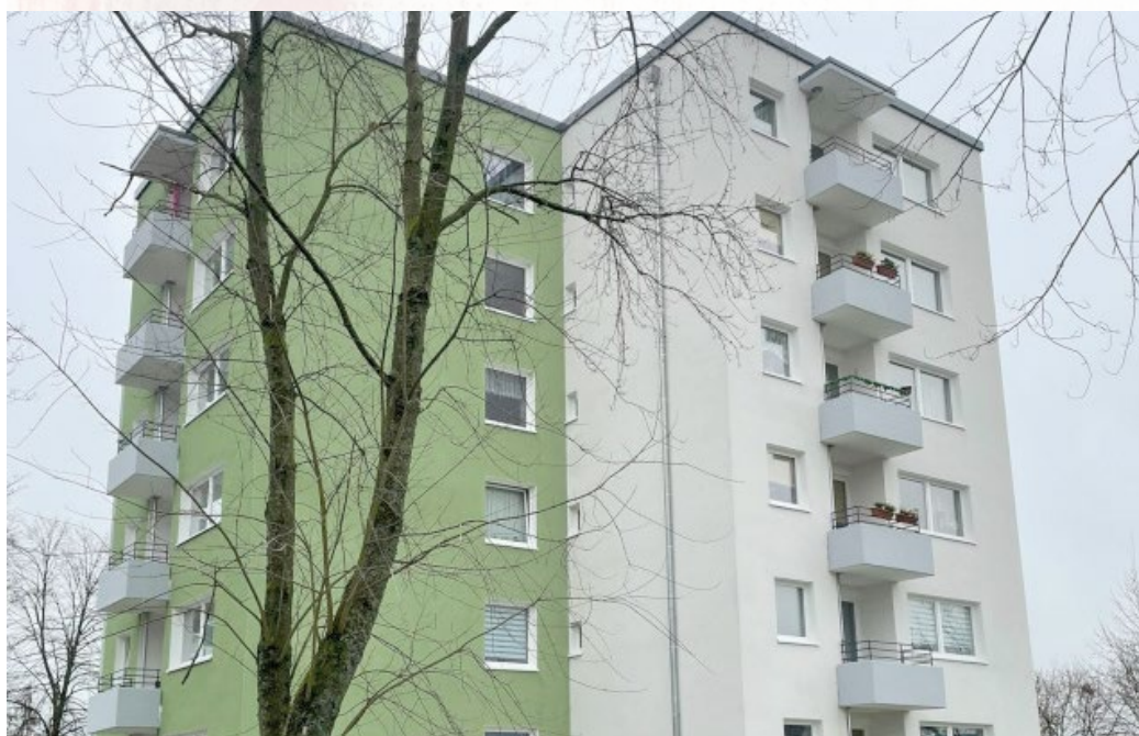
Das erste Gebäude im Rahmen der Gesamtmaßnahme „Hasenberg“ ist komplett saniert. Ein frischer Fassadenanstrich verleiht dem Ausdruck. Foto: Gewag
