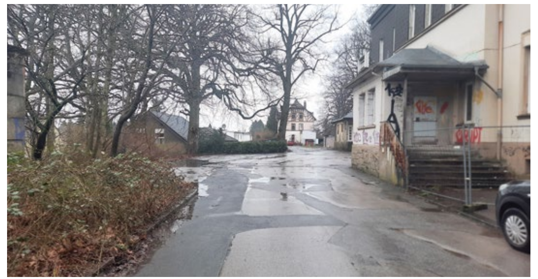
Im Zuge der auf dem Bahnhofsvorplatz geplanten Modulbauten soll das marode Bahnhofsgelände saniert werden. Foto: LIA Archiv
