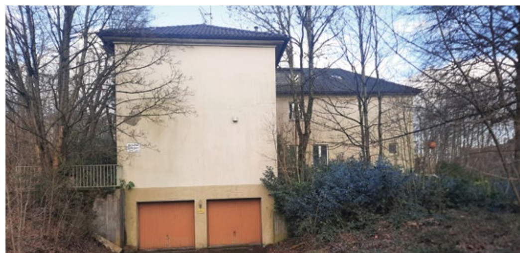
Hier mäht schon lange niemand mehr Rasen oder schneidet Sträucher. Von der Hackenberger Straße ist das leer stehende Gebäude kaum noch sichtbar. Foto: Bona
