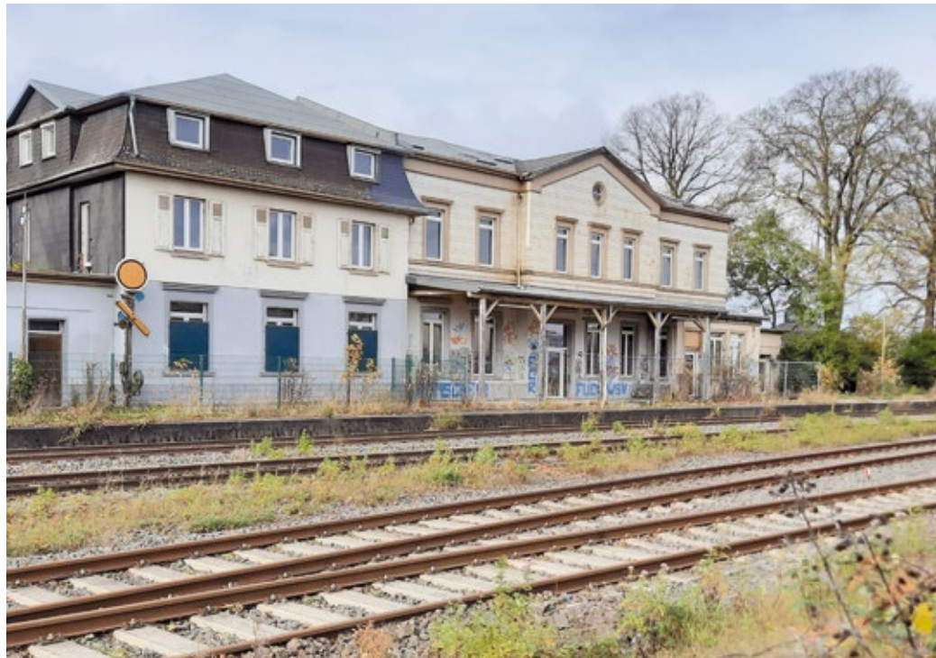
Der Lüttringhauser Bahnhof steht seit längerer Zeit leer, obwohl mit dem Umbau für Wohnzwecke bereits begonnen wurde. Unter anderem wurden neue Fenster eingesetzt.
