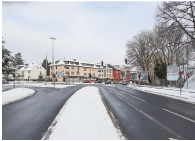
Bis Herbst 2025 soll die Kreuzung Eisenstein ein völlig neues Gesicht erhalten.
