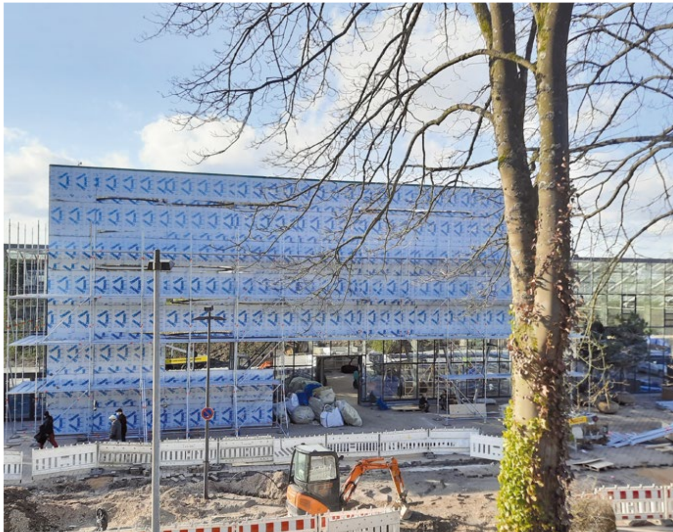
Der Baufortschritt ist täglich sichtbar. Die Fassade rund um den Eingang wird mit 100 Bäumen begrünt.
