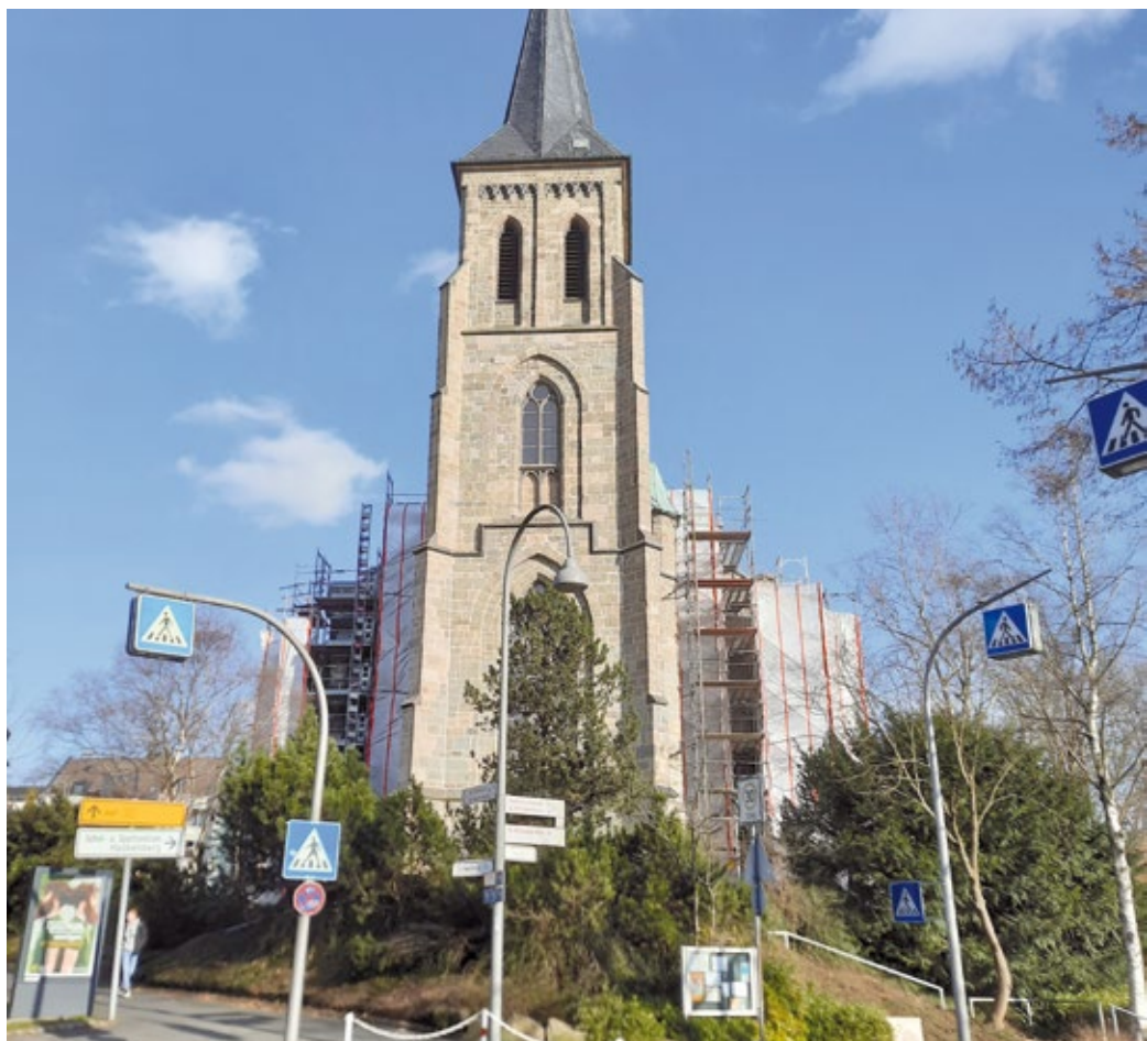
Das Bild der eingerüsteten Kirche an der Hackenberger- und der Hardtstraße wird sobald wohl nicht verschwinden. Foto: Bona
