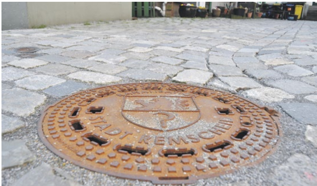
Remscheider Kanaldeckel sind in Lennep nicht gern gesehen - hier an der Stadtkirche. Foto: am
