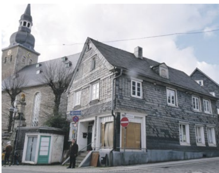
... und nach dem Bau der Bretterbude.
