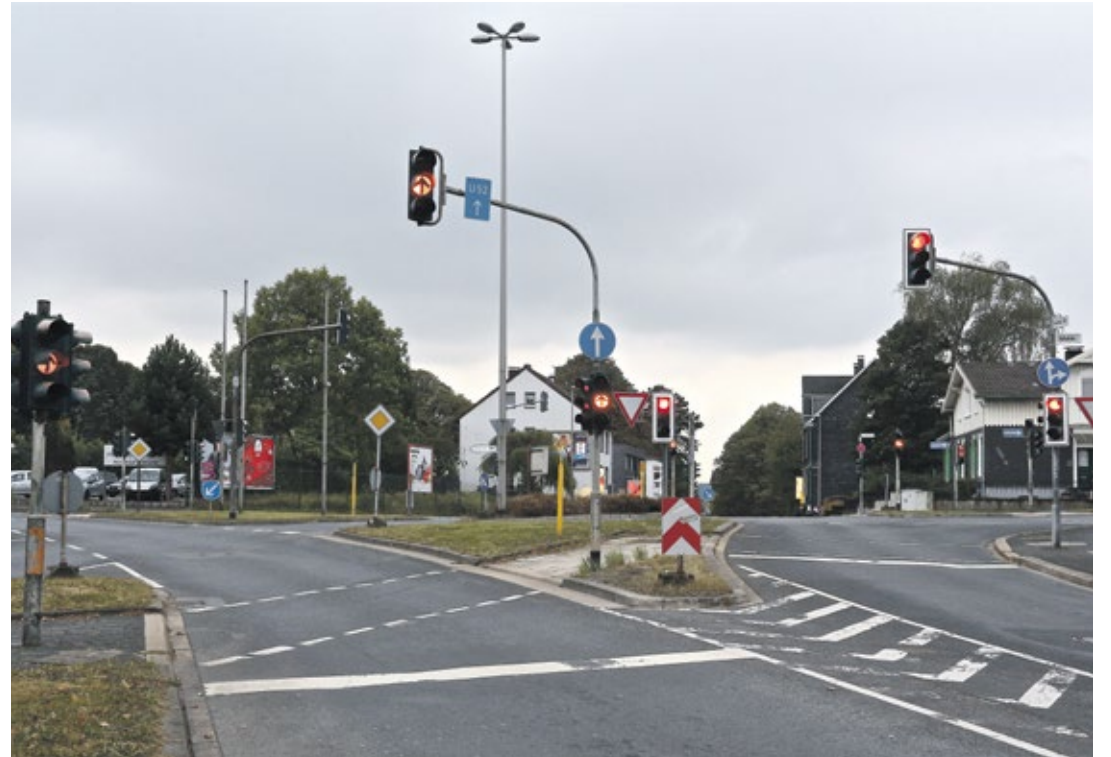
Die Kreuzung Eisenstein, Zustand heute.
